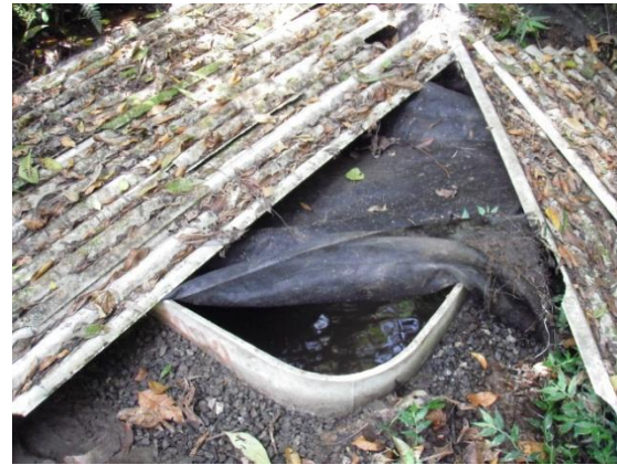
APÊNDICE 3.6.AR. Olho d'água protegido por cúpula de concreto (Fonte Roquete Pinto).
