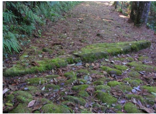
APÊNDICE 4.1.G. Canaletas de escoamento de águas pluviais
